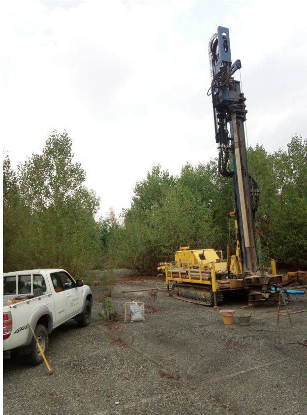
Posizionamento sondaggio S1Pz
