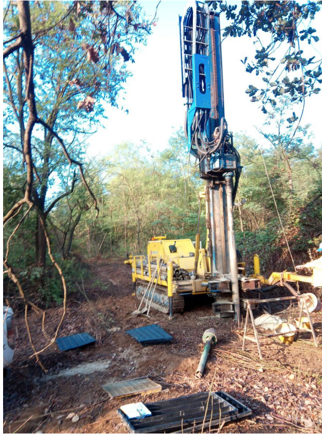
Posizionamento sondaggio S9Pz
