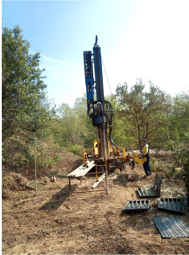
Posizionamento sondaggio S6Pz
